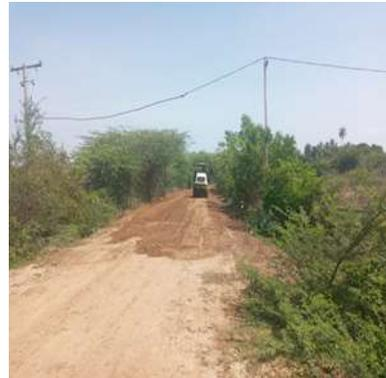
Relleno con material seleccionado para la corona del dique existente (K8+191.11 / K3+900).
